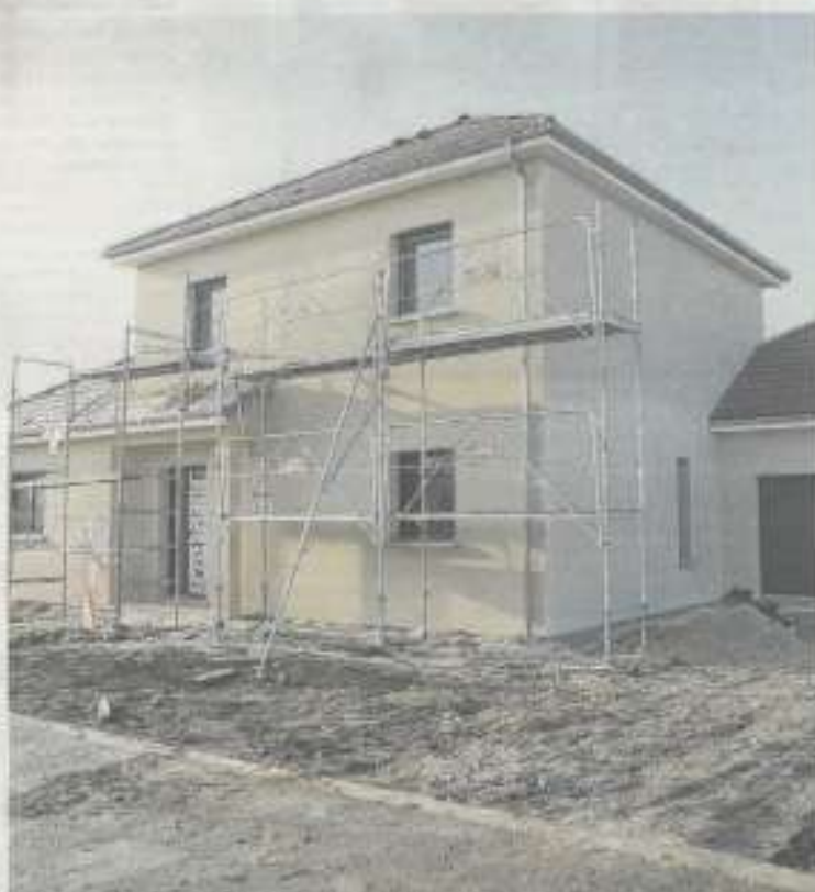
Maison en construction dans un lotissement neuf à Buchères. Photo: Luciane PÉROU
