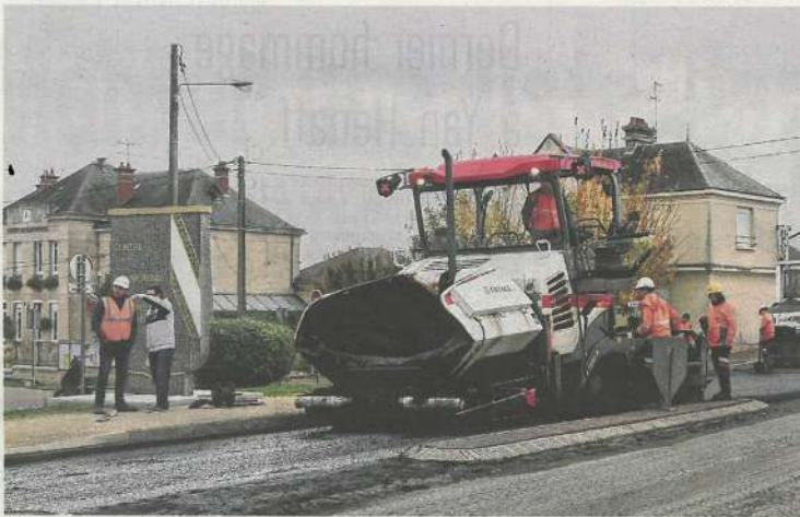
L'accès au centre commercial a été un temps perturbé.
