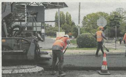
Un enrobé tout neuf pour l'avenue des Martyrs-du-24-Août.
