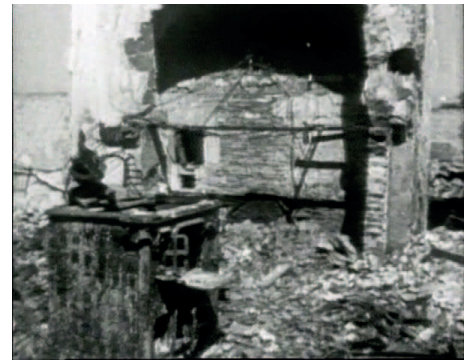
Une maison détruite
