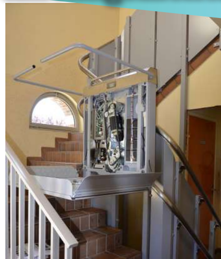
Club Ados : Installation d'un ascenseur adapté à l'handicap.
