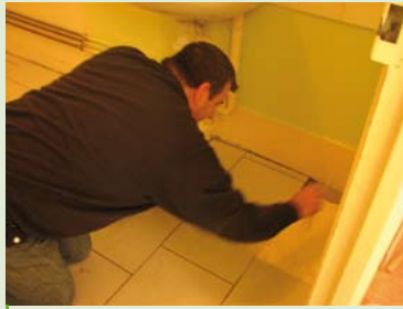
Réfection d'un logement communal
