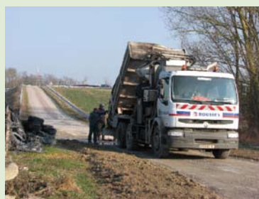
Réfection du chemin de la Voie de Vaux
