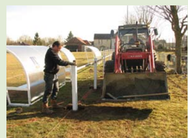
Pose de barrières de sécurité le long du stade de foot
