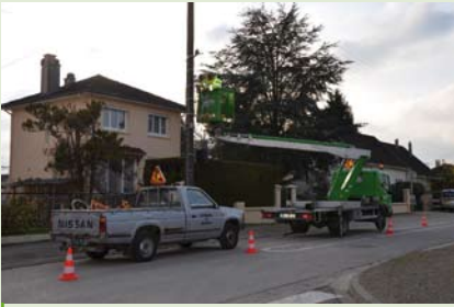
Installation des illuminations de Noël
