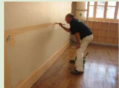
Réfection d'une salle de classe
