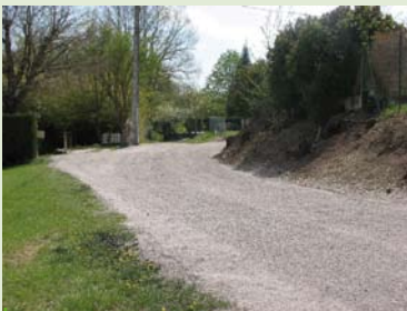
Réfection du chemin des Vigneux
