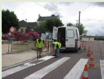
Réfection des bandes signalétiques
