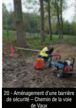
20 - Aménagement d'une barrière de sécurité - Chemin de la voie de Vaux
