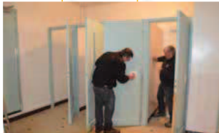
3 - Réfection des peintures des sanitaires des écoles (AVANT)
