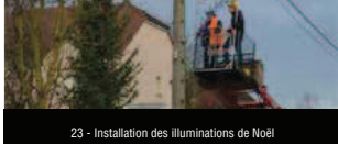
23 - Installation des illuminations de Noël
