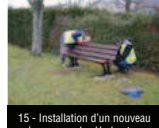
15 - Installation d'un nouveau banc - rue des Herbauates
