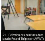
21 - Réfection des peintures dans la salle Roland Thépenier (AVANT)
