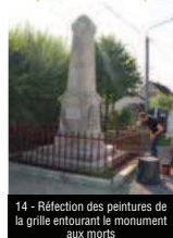
14 - Réfection des peintures de la grille entourant le monument aux morts
