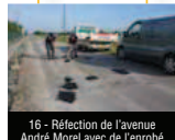
16 - Réfection de l'avenue André Morel avec de l'enrobé à froid
