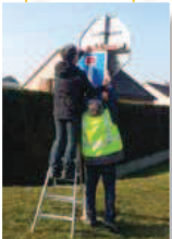
1 - Installation d'un panneau de voie sans issue Rue des Navettes
