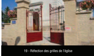
19 - Réfection des grilles de l'église
