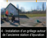
4 - Installation d'un grillage autour de l'ancienne station d'épuration
