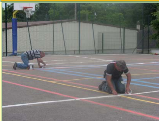
Rénovation des peintures au sol du terrain multi-activités
