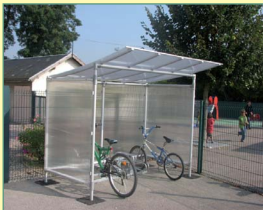
Installation d'un abri vélos dans la cour de l'école primaire
