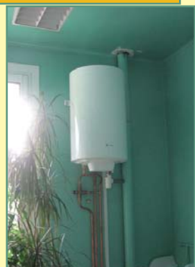
Changement du chauffe-eau mural école maternelle
