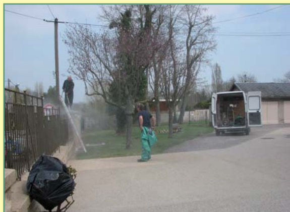
Nettoyage du mur d'enceinte de la Mairie
