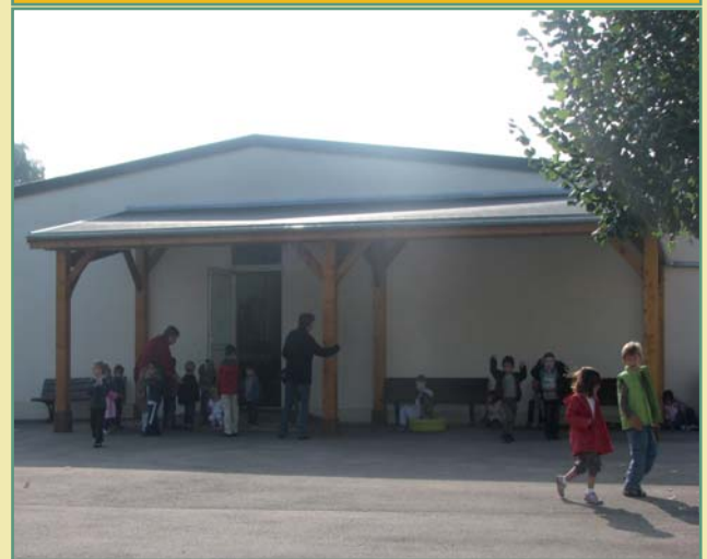
Construction d'un préau à l'école maternelle
