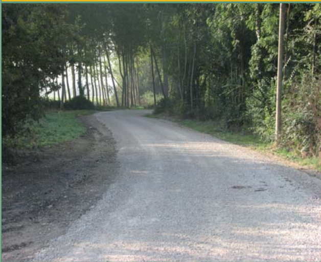
Réfection du Chemin de la voie de Vaux
