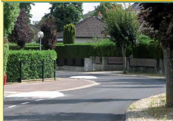
Réfection de la chaussée Rue de l'Hozain
