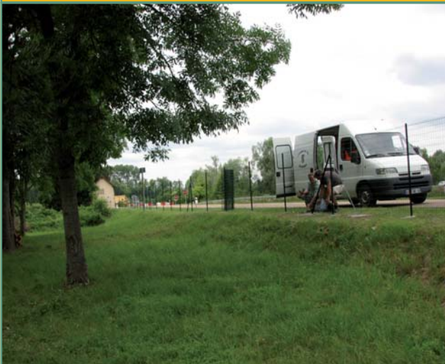
Fin de l'installation des clôtures au trou des Marots
