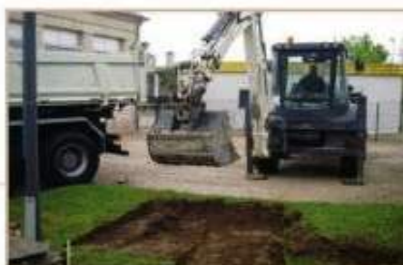
REAMENAGEMENT DU PARKING DE LA MAIRIE
