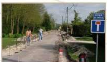
REFECTION DES CHAUSSEES ET BORDURES
